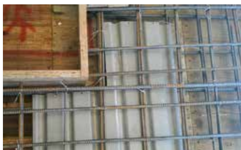
▲使用 L 型波浪鋼板來做角隅補強
