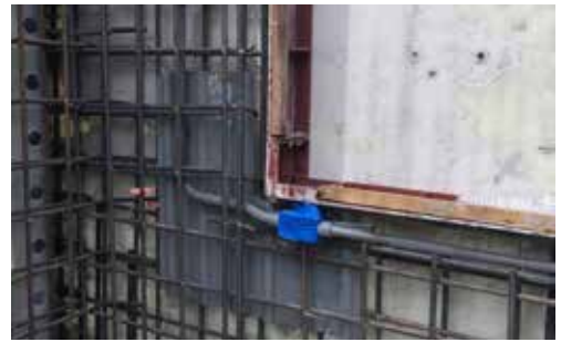
▲使用 L 型波浪鋼板來做角隅補強
